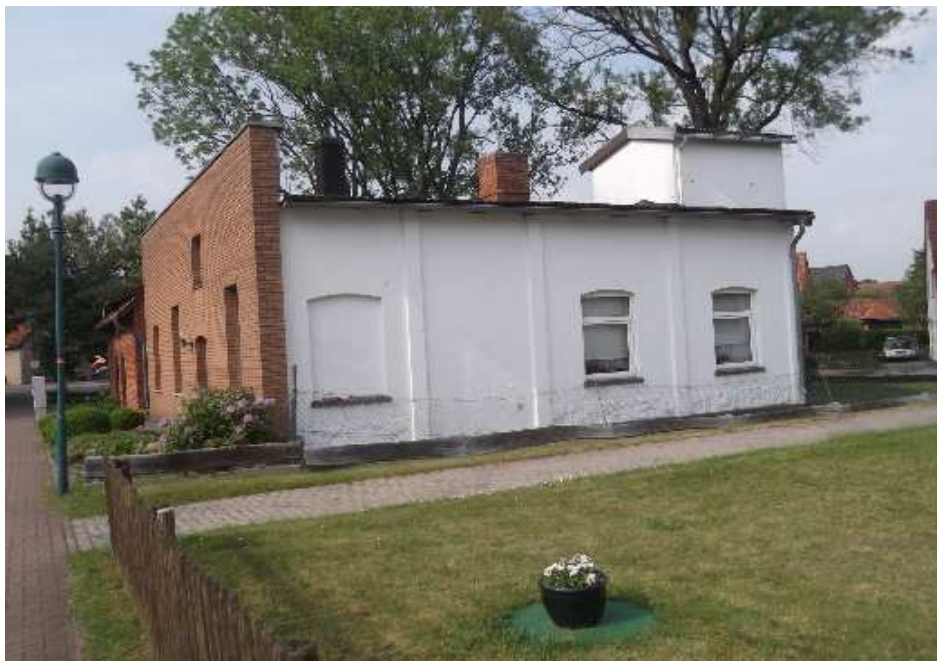
Elektrizitätswerk Liebenau, Schloßstraße 1 Vor der Klinkerverblendung des Giebels war dort stolz die Jahreszahl 1912 zu lesen. © Heimatverein Liebenau
