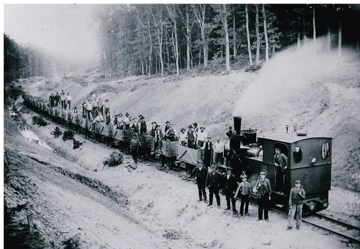
Bau der Eisenbahnstrecke im „Binner Holz“ (1908/1909). © Günter Mootz, Uchte
